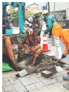
根元を除去しています
